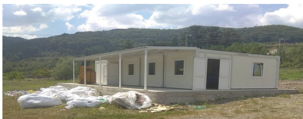
Slika br. 2. Reciklažno dvorište, na desnoj terasi reke Rasine
