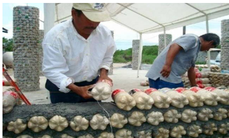
Slika 2. Povezivanje plastičnih boca najlonskim kanapom [10]
