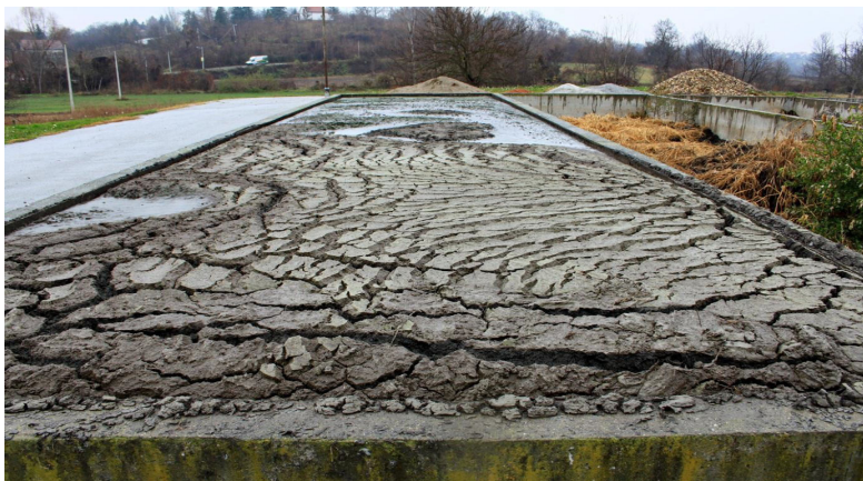
Slika 1. Gravitaciona polja za dehidrataciju mulja na PPOV „Kamenica“ 2017. god.
