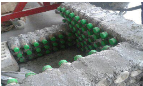
Slika 1. Zid od plastičnih boca [9]
